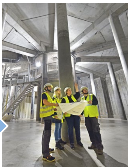
Bassin de stockage-restitution des Vergnes
