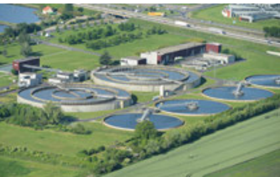
La station d'épuration des Trois rivières @Photo Joël Damase
