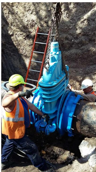
Pose de la vanne DN600 sur le refoulement du Cendre
