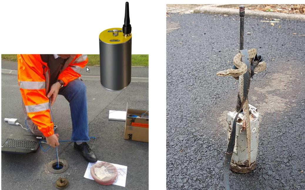
Installation/vérification d'un capteur acoustique fixe (avec parfois une surprise)
