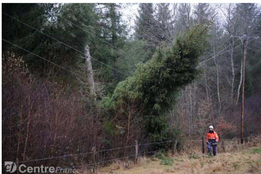
Dégâts provoqués par la tempête ZEUS sur une ligne électrique
