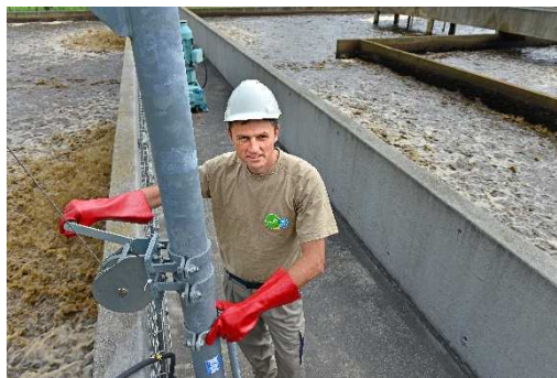
Opérateur usines assainissement en opération de maintenance
